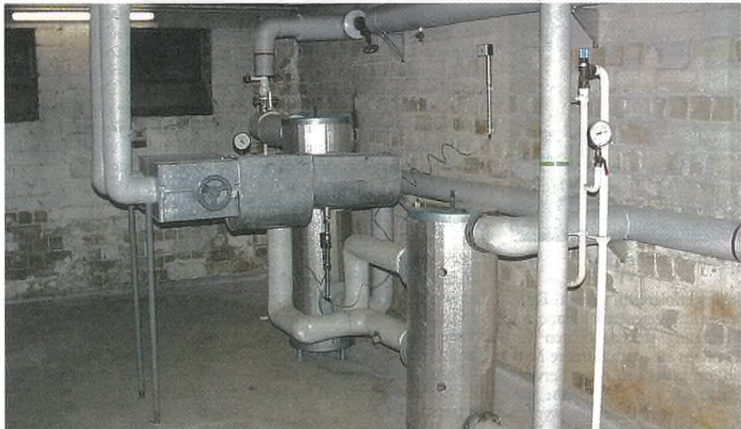
Die Rohre in den Heizungskellern wurden – wenn nötig – gegen Schwitzwasser isoliert und mit einer Wärmedämmung versehen.
